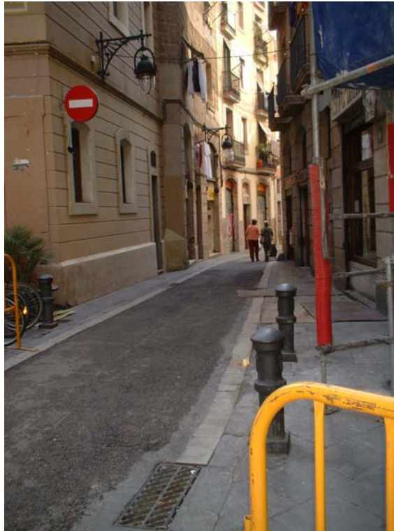
Fotografia 1: Vista general del carrer de les Ramelleres des de l'encreuament amb el carrer dels Tallers.
