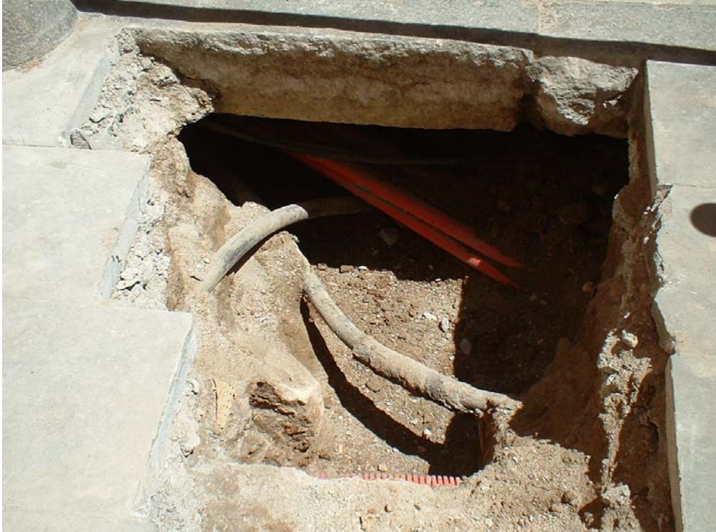
Fotografia 5: Vista de la cata per trobar la connexió del enllumenat públic.
