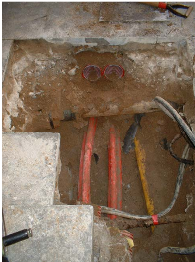
Fotografia 4: Els dos tubulars buits instal·lats amb anterioritat.
