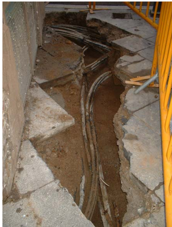
Fotografia 2: Vista general del tram de rasa al carrer Tallers, fins a l'E.T. del núm. 43.
